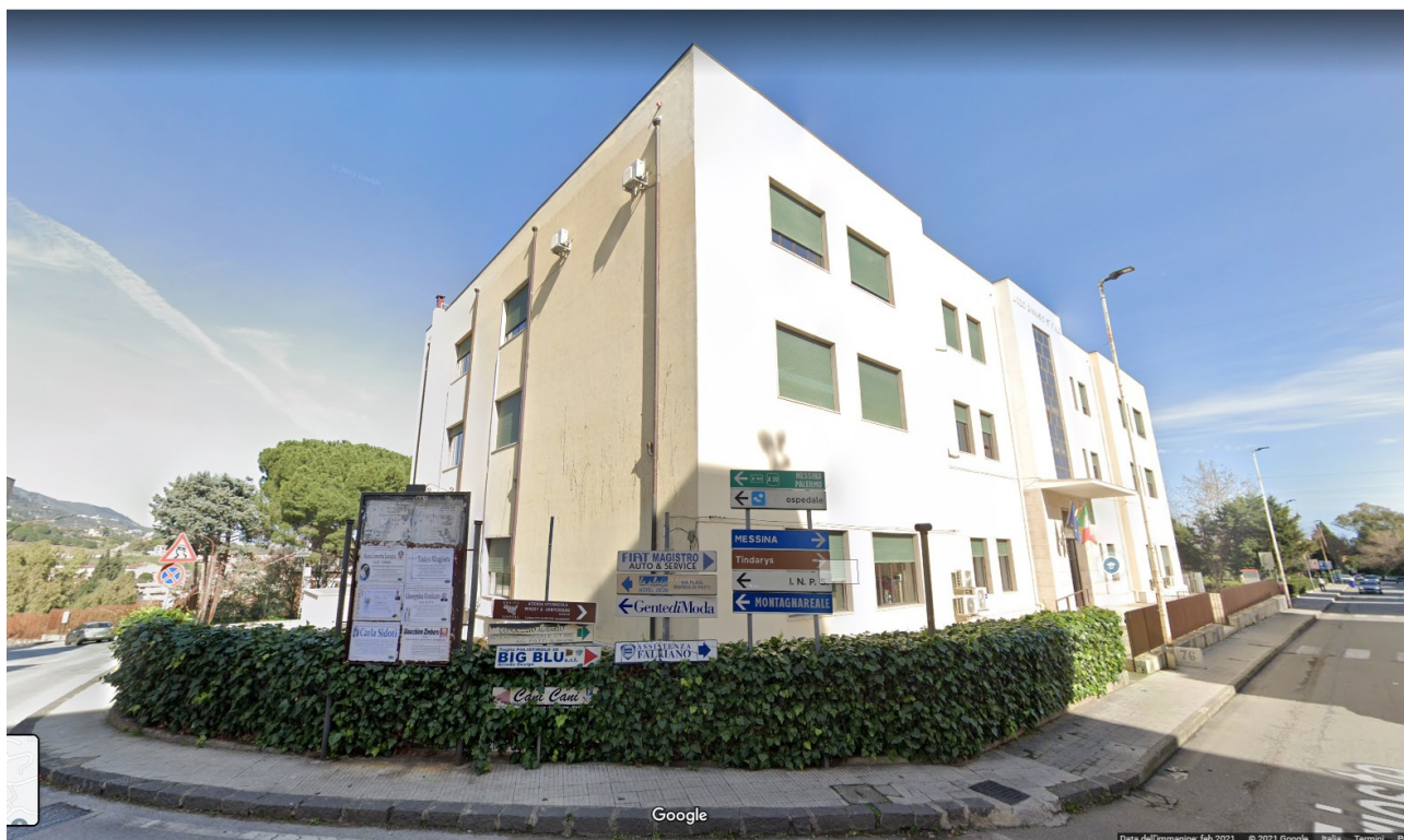
Fig. 3 – veduta prospettica facciate SUD-EST del plesso scolastico (immagine Street View)
